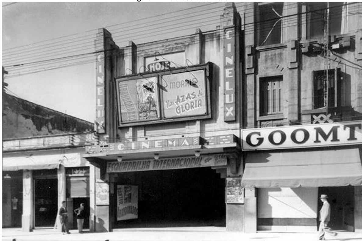
Figura 17: Fachada do CineLux.
