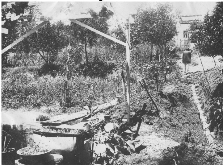
Figura 7. Fotografia de Geraldo Paula Souza de um poço contaminado pelo esgoto doméstico. À direita, observar a rede de esgotos em manilhas cerâmicas.
