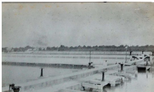
Figura 5. Tanques de decantação. Fotografia de Geraldo Paula Souza, Coleção Estados Unidos (GH037a).
