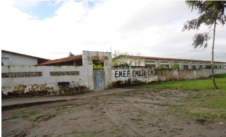
Foto 06 – Frente da EMEF Emília Cavalcante Morais Neta
