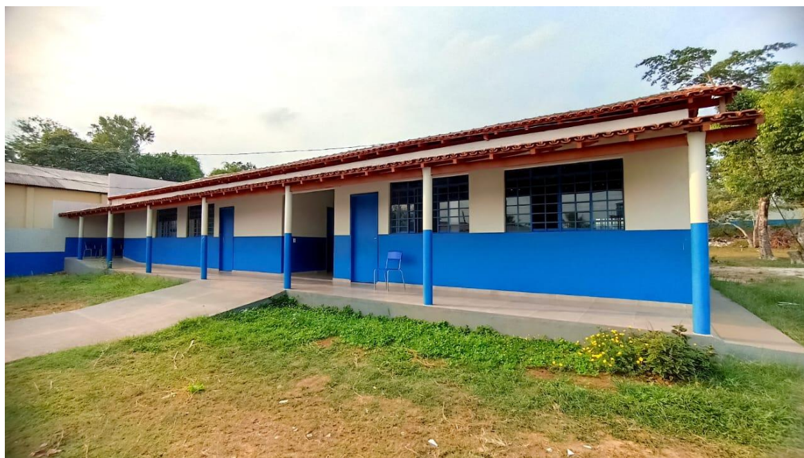
Figura 01: Escola Nova Canaã após reforma em 2023
