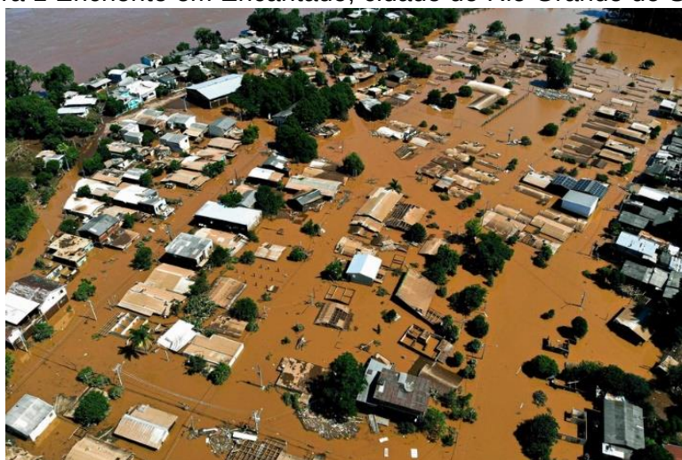
Figura 1 Enchente em Encantado, cidade do Rio Grande do Sul
