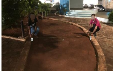
Imagem 2 – Medindo o canteiro
