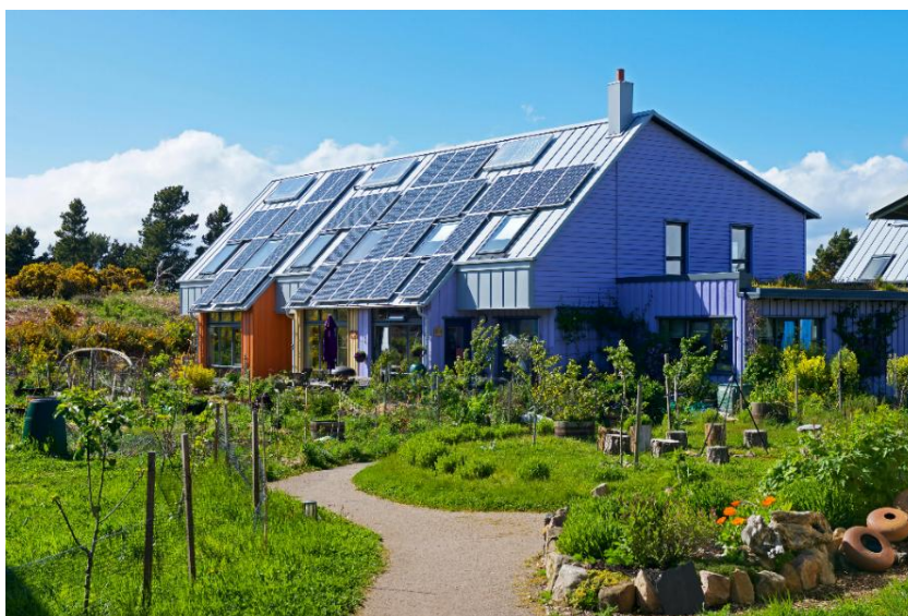
Figura 3 – Casa com painéis solares em Findhorn
