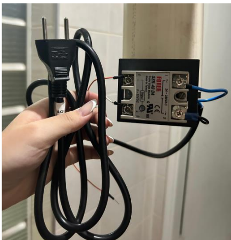
Figura 2: Relé de estado sólido acoplado ao suporte. Fonte: próprio autor.
