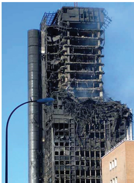
Figura 1: Colapso da estrutura após o incêndio da Torre Madrid Windsor (Espanha, 2005). (So, 2016)
