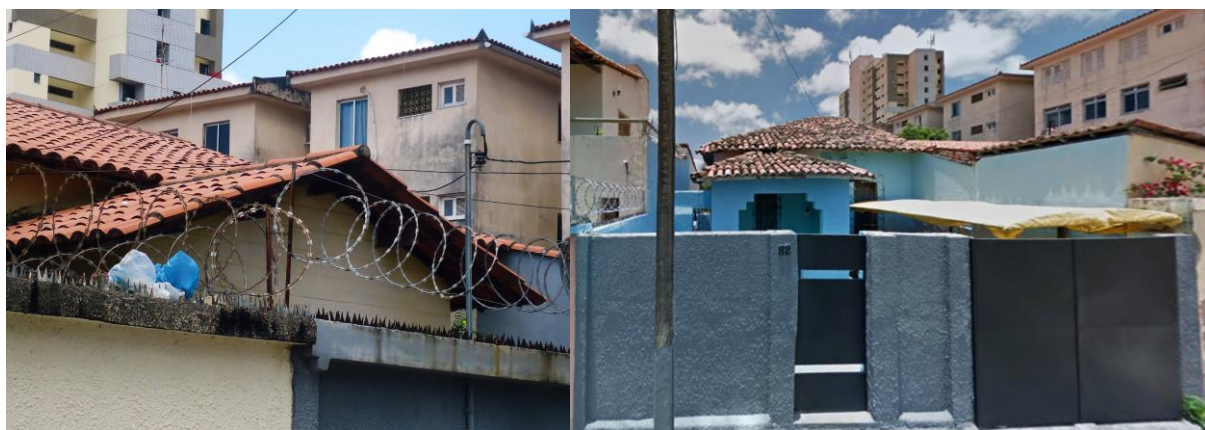
Figuras 14 e 15: Casa remanescente da Vila Ferroviária da Aldeota
