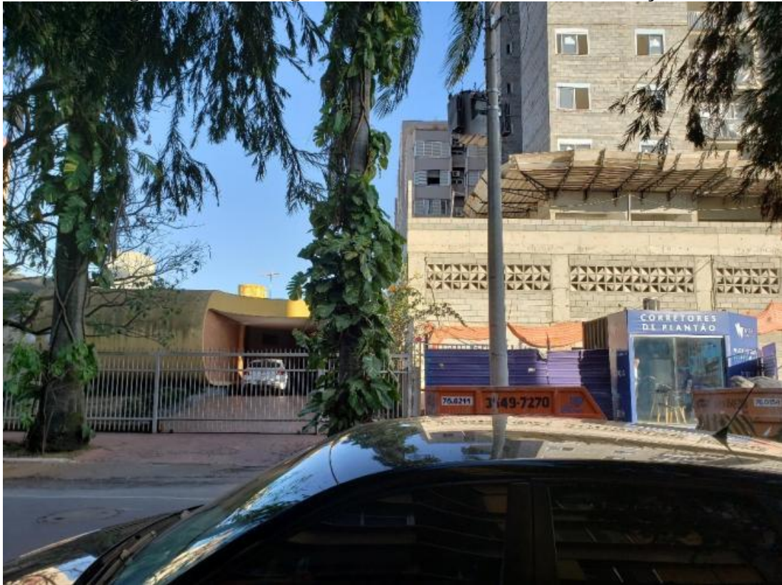
Figura 2 Casa antiga ao lado de um edifício em construção
