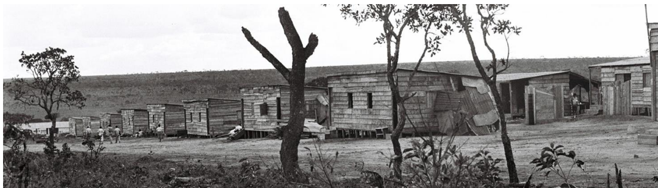
Figura 2: Alojamentos para operários. Fonte: Arquivo Público do Distrito Federal.
