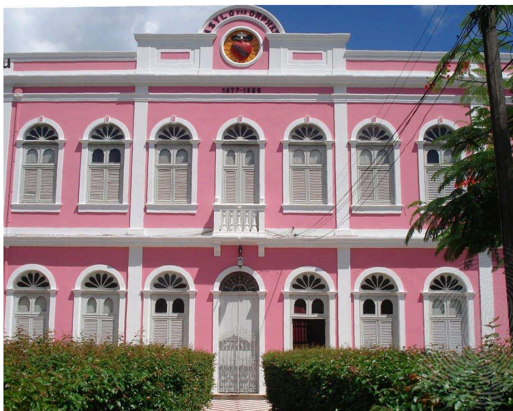
Figura 5: Escola Estadual Nossa Senhora do Bom Conselho, patrimônio histórico de Alagoas. Fonte: Portal de Arquitetura Alagoana (2018).
