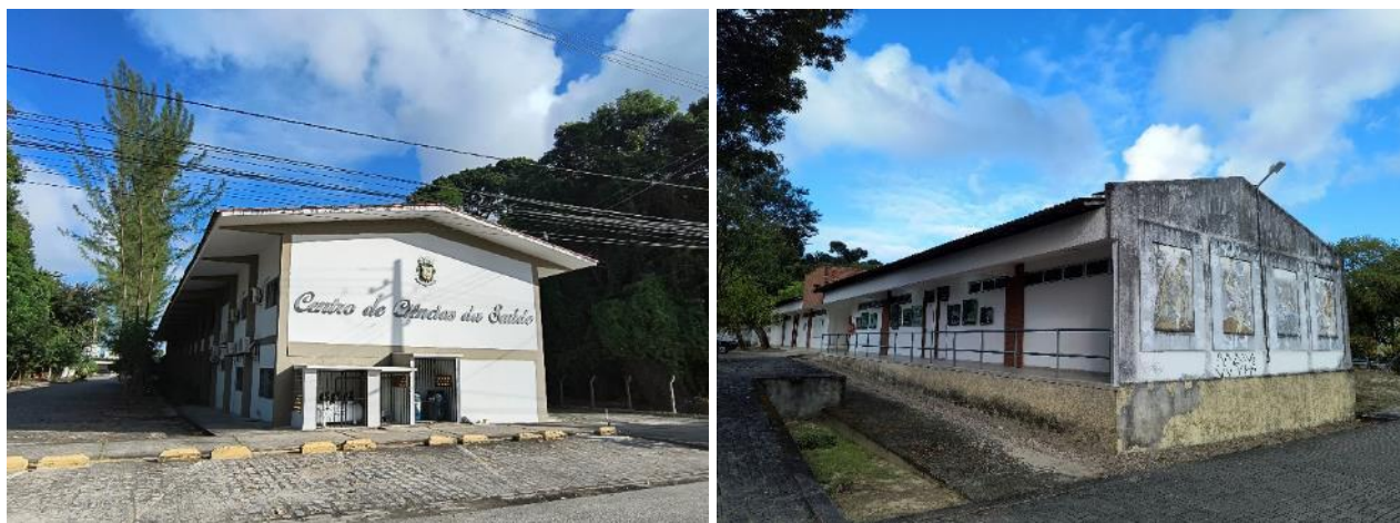
Figuras 14 e 15: O prédio da Direção do Centro de Ciências da Saúde - CCS, à esquerda. Ao lado, bloco destinado às atividades de diversos cursos do CCS. A opção pelos galpões pré-moldados em concreto marcou fortemente a produção do terceiro período. Fotos realizadas pelo autor, 2024.
