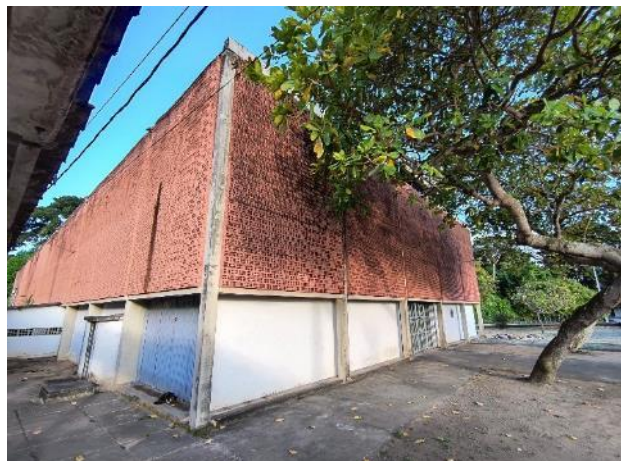
Figuras 24 e 25: As Oficinas Hidráulica e Mecânica, respectivamente, com sua tipologia peculiar; no térreo as vedações e aberturas, na parte superior as quatro fachadas com seus “panos” de cobogós proporcionando a ventilação cruzada e pé-direito quase triplo. Fotos realizadas pelo autor, 2024.
