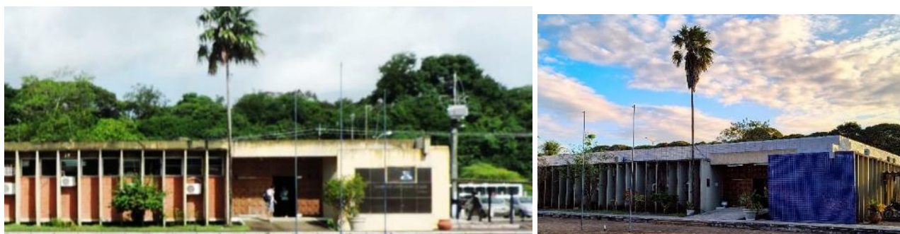
Figuras 32 e 33: Prédio Administrativo do CT em 2015 com sua volumetria original – viga de bordo fazendo às vezes de platibanda, e parede em concreto aparente marcando o acesso principal. À direita, vista atual do edifício após obra de manutenção da coberta. Foto (Figura 32) realizada por Geórgia Ribeiro, 2015. Foto (Figura 33) realizada pelo autor, 2024.
