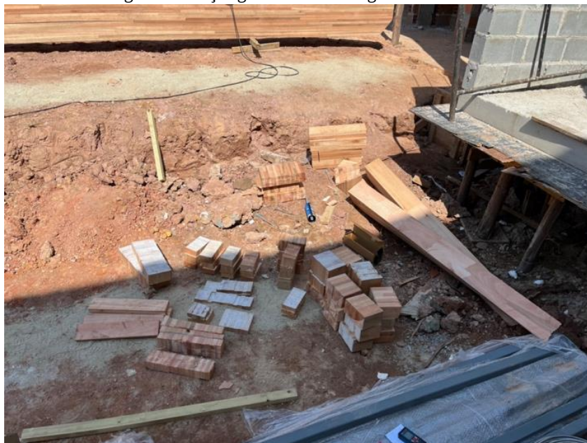
Figura 4 – Peças geradas na montagem da estrutura
