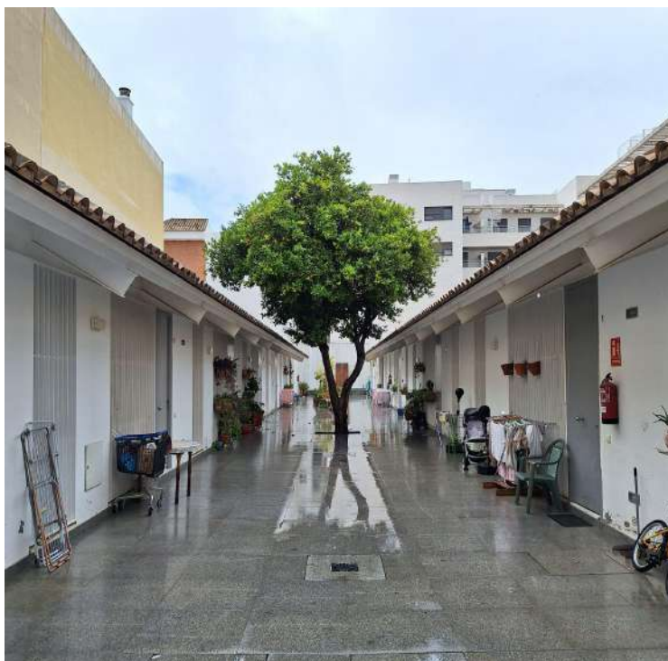
Figura 10: Corral de la Encarnación después de la rehabilitación. Fuente: Claudia Andreoli Muniz, 2024, autoría propia.
