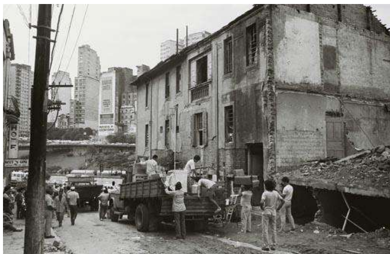
Figura 4: Calle Jandaia durante las demoliciones en 1987. Fuente: Fotografía de Israel dos Santos Marques. Acervo Fotográfico do Museu da Cidade de São Paulo.
