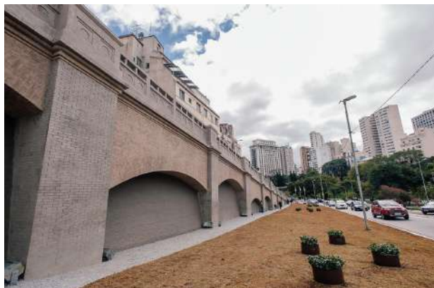
Figura 5: La pared estructural sin las casas, en 2017. Fuente: Fotografía de León Rodrigues/SECOM. APÓS RESTAURAÇÃO, 2017.
