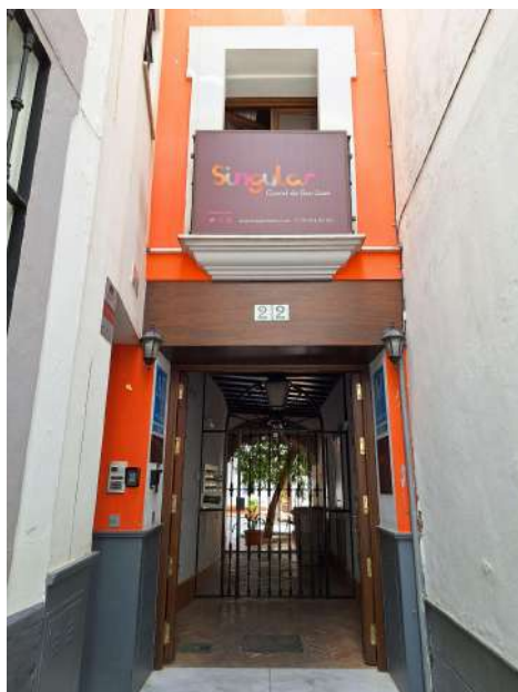
Figura 12: Corral San José después de la rehabilitación, con uso de apartamentos turísticos. Fuente: Claudia Andreoli Muniz, 2024, autoría propia.
