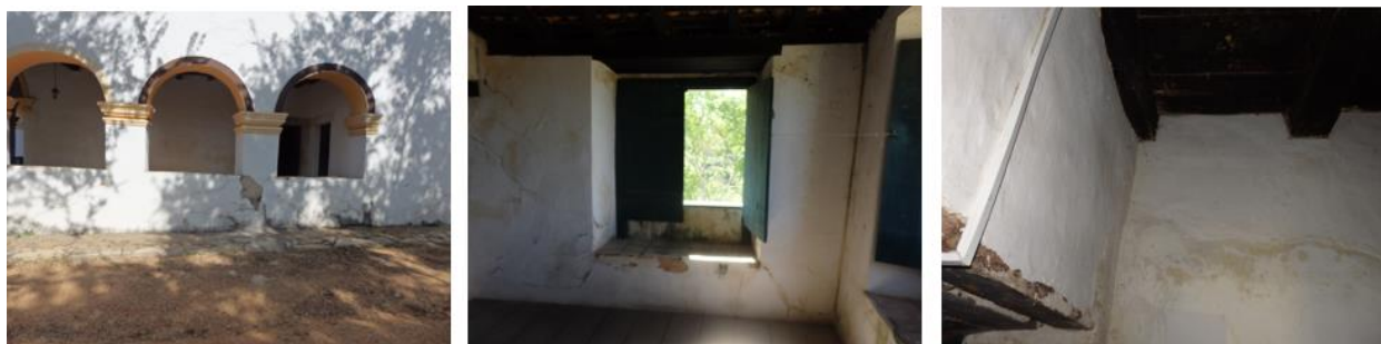
Figura 10: (esquerda) – Ataque por sais na fachada externa lateral oeste. (centro) – Ataque por sais na parede lateral oeste parte superior (galerias acima do avarandamento). (direita) – Ataque por sais na parede interna da Sacristia do lado esquerdo da capela-mor (lado oeste da Igreja). Fonte: Grupo de pesquisa PIBITI, nov. 2022.
