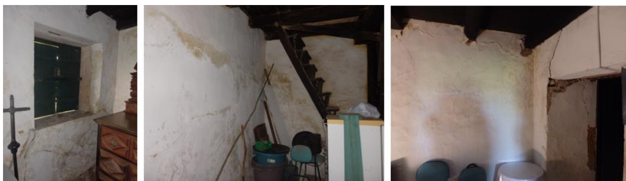
Figura 9: (esquerda) – Parede lateral interna da sacristia do lado direito do altar-mor (umidade condensação). (centro) – Parede atrás do altar-mor com alta concentração umidade condensação. (direita) – Detalhe da parede interna da sacristia do lado esquerdo do altar, umidade condensação acompanhada por uma das maiores fissuras encontradas na edificação, com grande perda de material (lado oeste). Fonte: Grupo de pesquisa PIBITI, nov. 2022.
