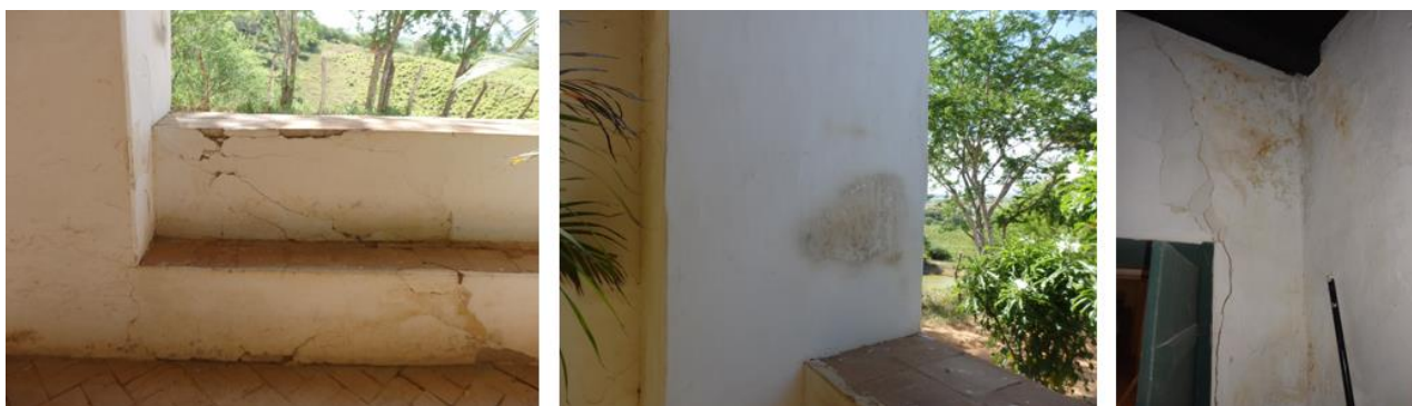
Figura 8: (esquerda) – Umidade nos bancos do avarandamento da fachada oeste. (centro) – Detalhe de infiltrações, mancha de umidade parede avarandamento fachada oeste. (direita) – Detalhe de umidade por condensação acompanhada por fissuras na sacristia do lado esquerdo do altar-mor (lado oeste). Fonte: Grupo de pesquisa PIBITI, nov. 2022.
