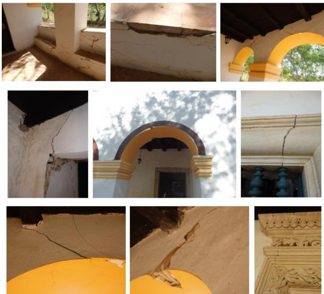
Figura 11: (acima - da esquerda para a direita) – Desagregações, esmagamento e fendilhações nos bancos e arcos do avarandamento da parede oeste. (centro - da esquerda para a direita) – Esmagamento e fendilhações na porta da sacristia; em um dos arcos do avarandamento com estabilização, ambos na parede oeste; fendilhação na pedra calcária da janela ao lado da portada principal. (abaixo - da esquerda para a direita) – Fendilhações com desagregação e esmagamento no centro dos arcos do avarandamento da parede oeste; fendilhação na portada principal em pedra calcária. Fonte: Grupo de pesquisa PIBITI, nov. 2022.
