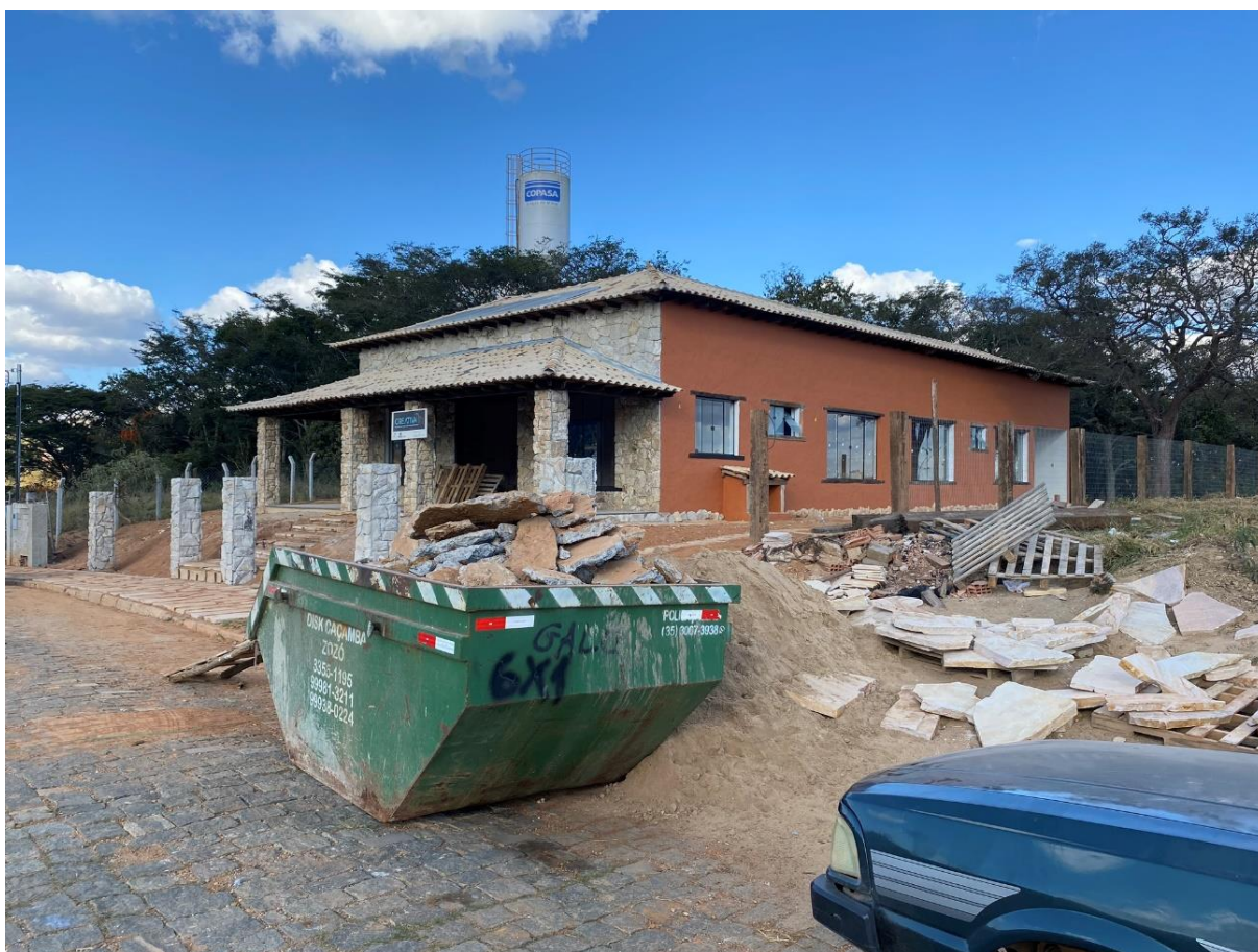
Figura 5: Edificação em construção, implantada da parte mais alta do Loteamento 01. Fonte: Acervo Pessoal, 2023.
