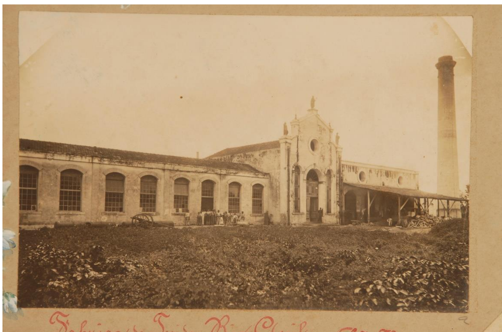
Figura 16: Fachada da Fábrica Fonte: Álbum de Gaudêncio Cunha, 1908
