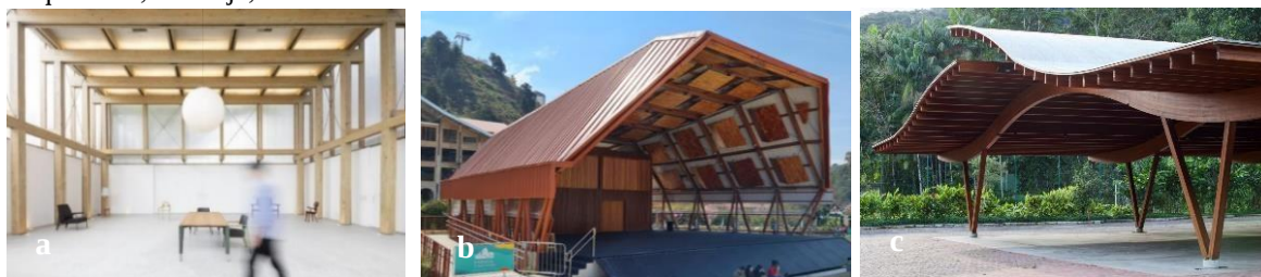
Fonte: a) https://rewood.com.br/cases/micasa . b) https://timbauestruturas.com.br/project/palco-campos-do-jordao/ . c) https://www.itaengenharia.com/projetos-de-construcao-com-estrutura-em-madeira/centro-de-eventos-iporanga . Acesso em 03/05/2024.
