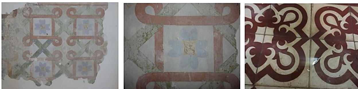
Figura 13: (esquerda) – Ataque intenso por umidade provocando desbotamento, amarelamento e descolamento da pintura. (centro) – Detalhe do desaparecimento da cor verde das faixas dos losangos diagonais (quadrados) e presença de esbranquiçamento (sabonificação) nos laçarotes vermelhos devido ao ataque por sais solúveis. (direita) – Presença de água no piso da capela-mor que escorre das paredes. Fonte: Grupo de pesquisa PIBIC, jul. 2023.
