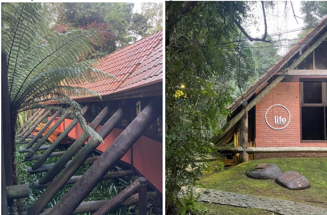
Figura 10 – Detalhe do bloco de trabalho (à esquerda) e do bloco administrativo (à direita)
