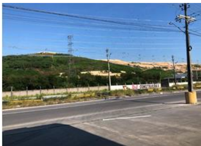
Figura 1. Aterro Sanitário de Resíduos Sólidos em Manaus. Fonte: Yasmin Angelim, 2024.
