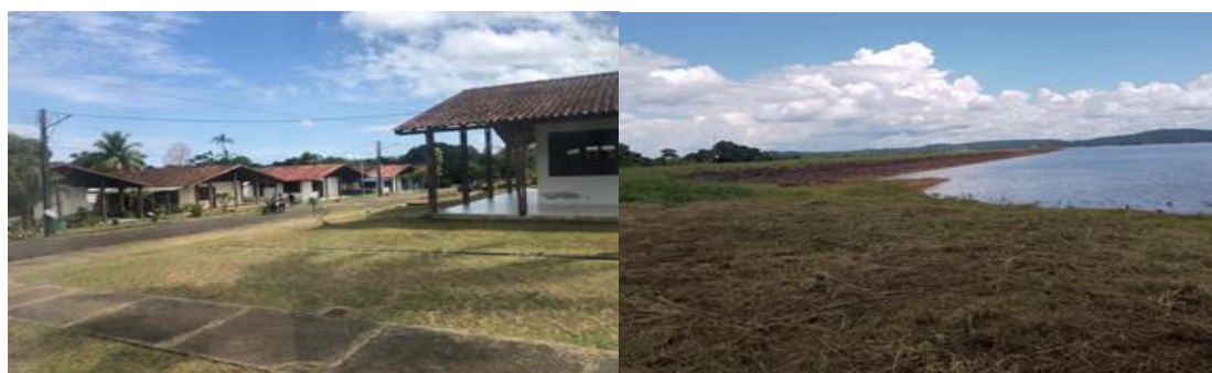
Figura 3. Vila de trabalhadores da hidrelétrica e parte da hidrelétrica de Balbina. Fonte: as autoras.
