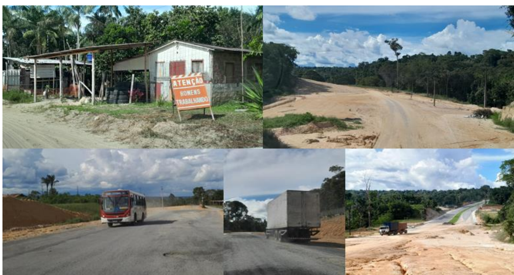
Figura 4. Obras do Anel Leste (Parte do Rapidão) com fluxos de caminhões e uma linha de ônibus alimentadora. Imagens do autor em 02 de maio de 2024.
