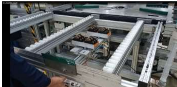
FIGURA 10. Posto de Reparo montado ao lado da esteira transportadora.
