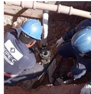
Desmontagem da válvula de bloqueio.
