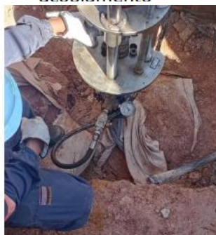
Instalação com mangote de nitrogênio realizada.
