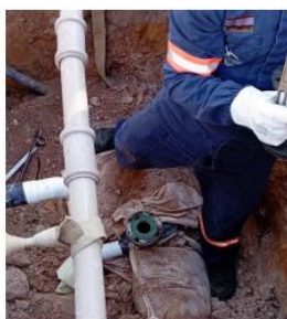
Posicionamento de junta de vedação.
