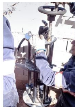
Verificação do movimento da fresa.
