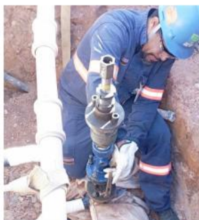
Posicionamento de junta de vedação.
