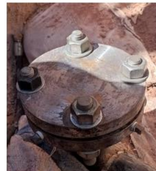
Flange cego instalado.
