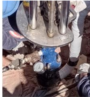
Conferência da estanqueidade do Stop Plug.
