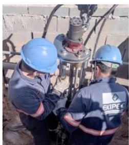
Remoção da máquina de furo – 1ª etapa
