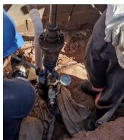
Remoção da máquina de furo – 2ª etapa
