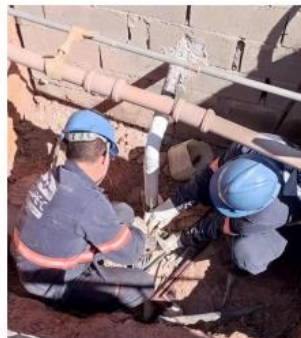
Instalação do flange cego.
