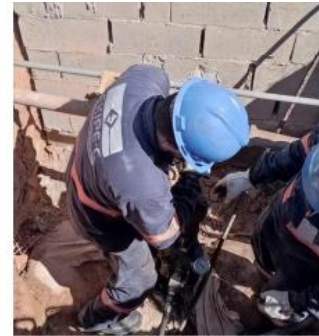
Desmontagem da máquina de furo.
