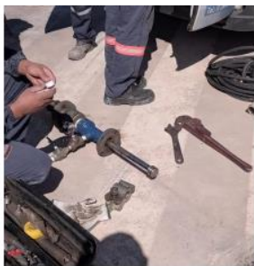
Stop Plug instalado na máquina.
