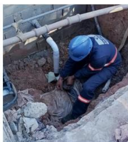
Instalação de batente.
