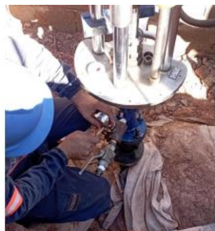
Instalação de instrumento de medição e válvula de alívio
