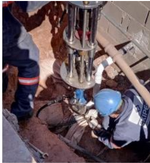
Travamento do Stop Plug no flange do fitting.
