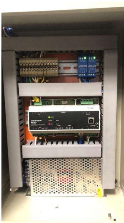
FIGURA 7. Quadro de controle com central de automação
