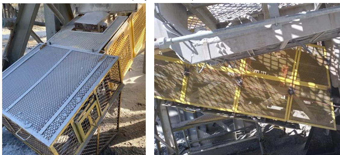
FIGURA 12. Adequação do transportador de correia.
