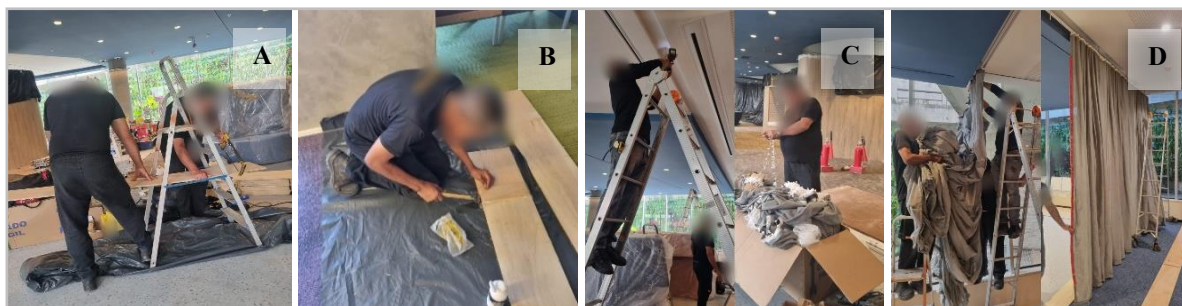
FIGURA 4 – Atividades do processo de instalação das cortinas sendo executadas
