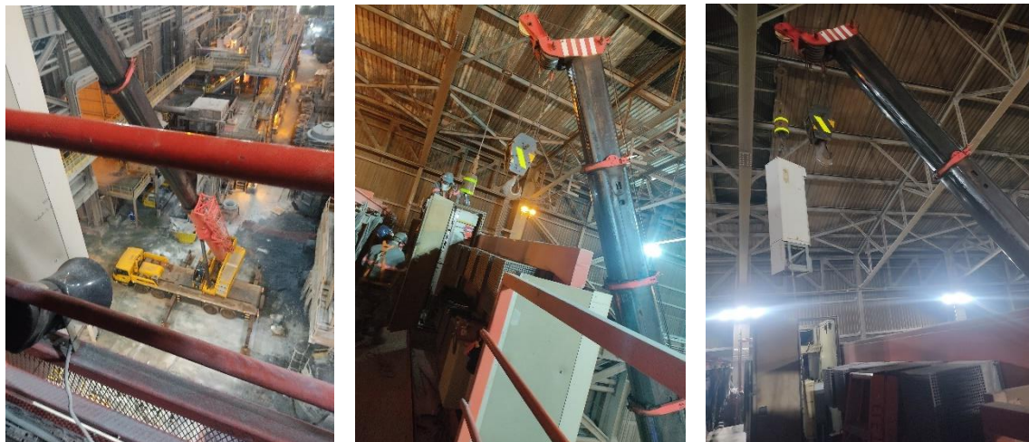
FIGURA 4. Utilização de guindaste na manutenção do Inversor de Frequência – Pontes Rolantes
