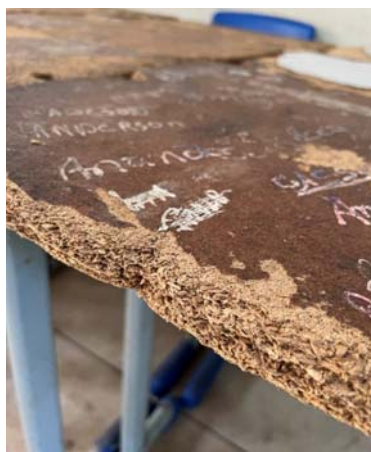
Figura 3: Tampo de mesa escolar da comunidade do Arai – Augusto Corrêa/PA. Fonte: Autoras, 2023.
