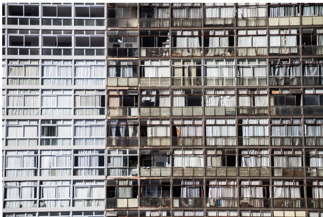
Figura 6: Fachada do Bloco A: contraste entre as esquadrias novas e antigas do edifício
