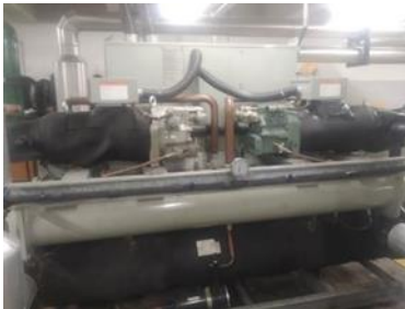
FIGURA 2. Fotos do dispositivo experimental implementado em campo, montagem da instrumentação no chiller .
