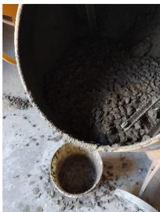
Figura 1. Fabricação do concreto
