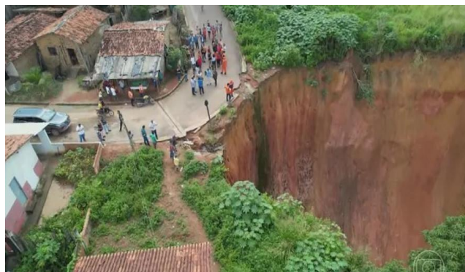
Figura 5: Área de Voçoroca em torno de Buriticupu
