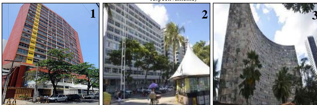
FIGURA 03, 04 e 05: Primeiros edifícios residenciais de Boa Viagem em Recife. (Califórnia - 1, Acaiaca - 2 e Holiday - 3, respectivamente)
