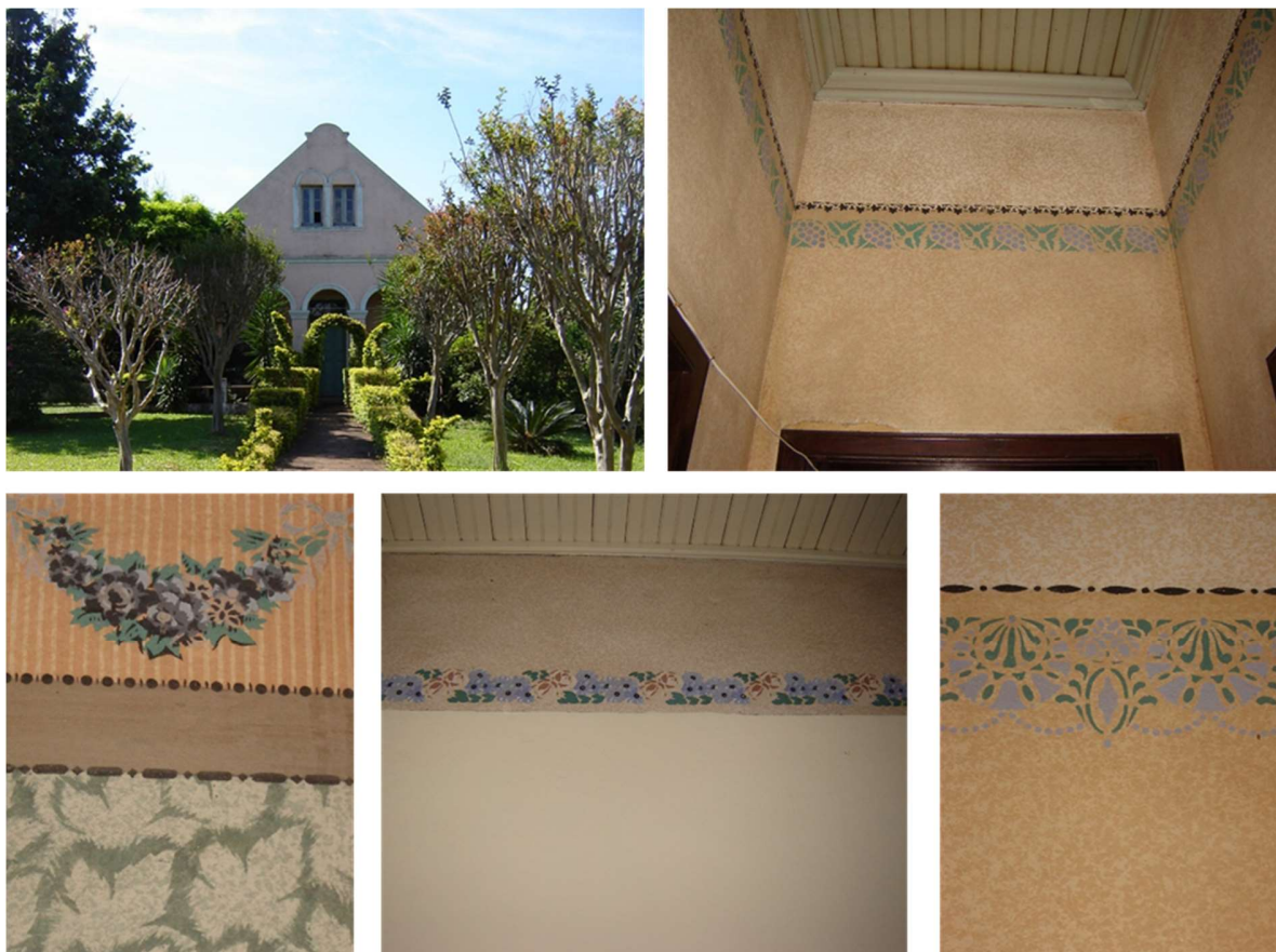
Figura 4: Casa Paroquial, Pirapó, construção de 1932.
