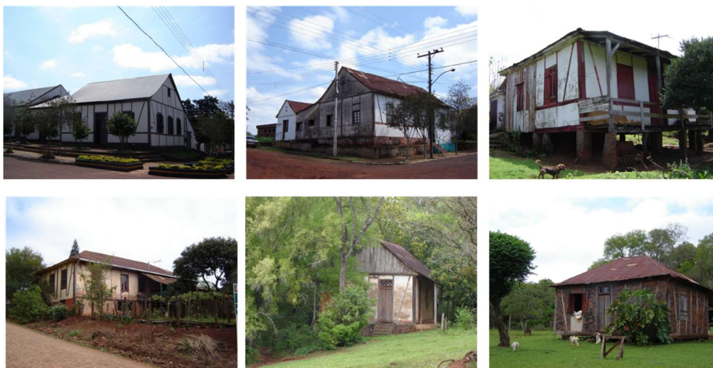
Figura 11: a) Biblioteca Pública Municipal; b) Lavanderia do Hospital; c) Casa Sphis; d) Casa Henrique Sommer; e) Casa Sommer 2; f) Casa Rambo
