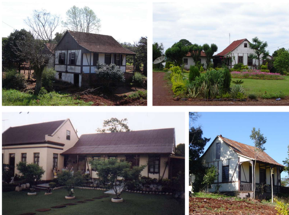
Figura 5: Edificações com estrutura em enxaimel. a) Casa Assmann, Cerro Largo; b) Casa Jacó Bervanger, São Pedro do Butiá; c) Casa Rudi, São Pedro do Butiá; d) Casa Guilherme Konzen, Cerro Largo
