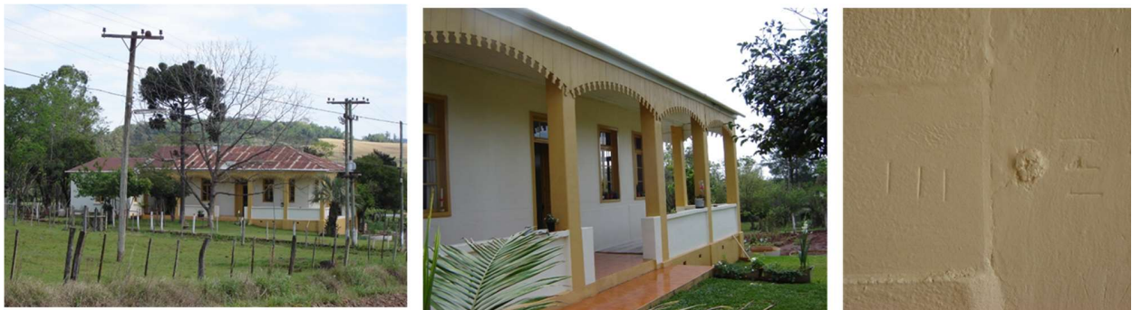
Figura 2: Casa Pedro Hoffmann Pirapó Construção de 1936, em enxaimel, seu madeiramento ainda se encontra numerado, com cozinha separada do corpo principal
