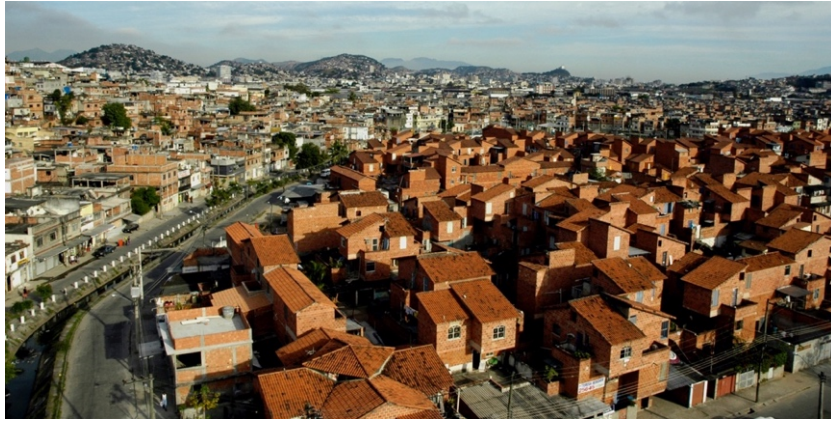
Figura 2: Implantação do Conjunto Nova Maré. Fonte: Francisco Valdean, Imagens do Povo.
