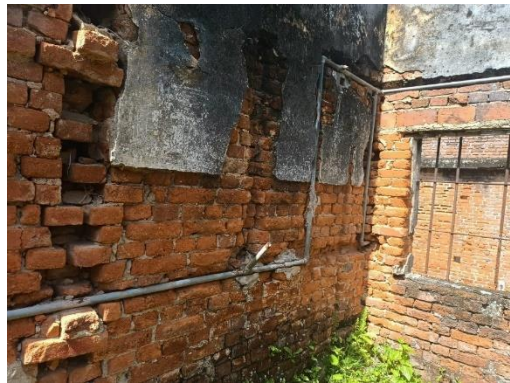
Figura 7 - Detalhe das instalações hidrossanitárias
