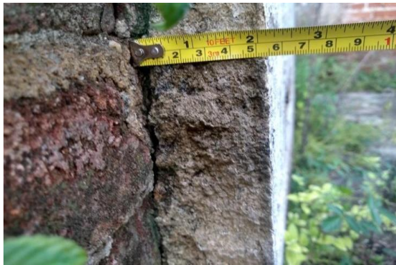
Figura 6 - Detalhe do revestimento argamassado da alvenaria
