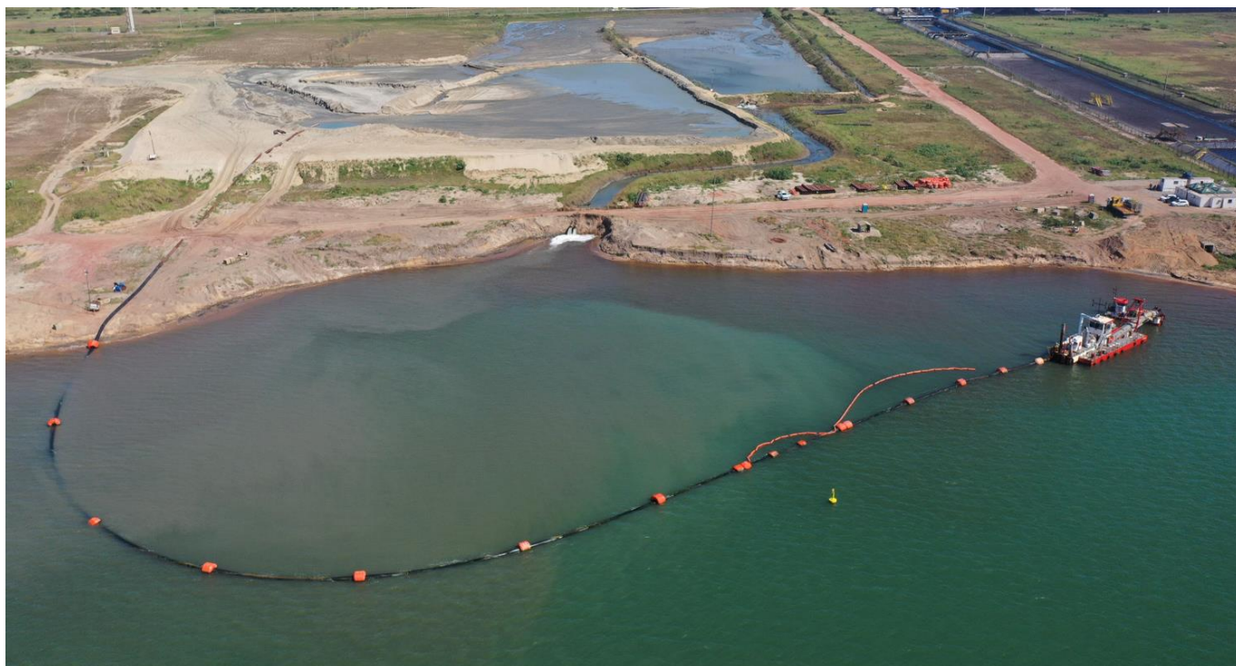
FIGURA 3: Visão aérea da área de operação da dragagem de implementação para expansão do cais, evidenciando a dificuldade para realização de um levantamento hidrográfico convencional.
