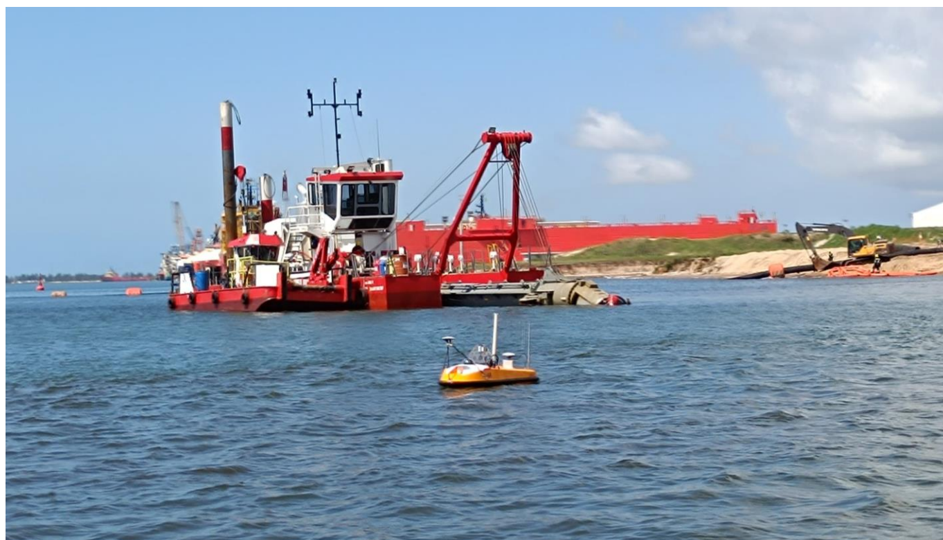
FIGURA 2: Levantamento hidrográfico com ASV durante a operação da dragagem.
