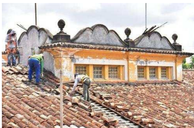
Figura 8 – Reparo do telhado do Mercado do Porto do Sal por meio do Projeto Mastarel. Fonte: Projeto Mastarel (2024).
