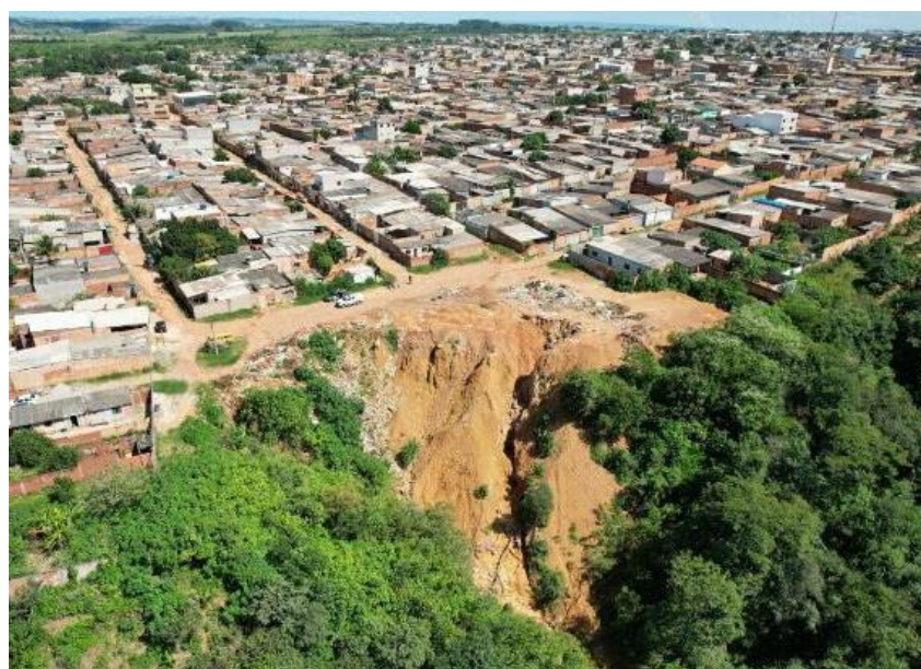
Figura 5 - Processo erosivo na RA Sol Nascente/Pôr do Sol. Fonte: Valmor Pazos Filho (Plano Comunitário de Redução de Risco no Sol Nascente. Coordenação geral: Liza Andrade) (2024).
