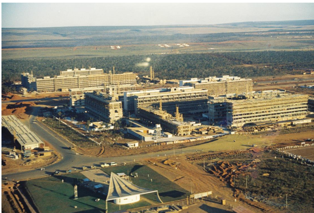
Figura 5 – Igreja Nossa Senhora de Fátima e, aos fundos, a quadra modelo em construção. Fonte: Arquivo Público do DF.
