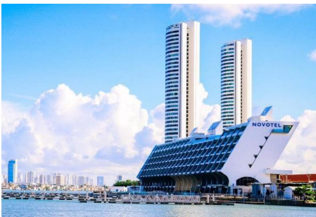
Figura 1 - Novotel Marina, em fase final das obras. Fonte: Gabinete do Centro do Recife (2024).
