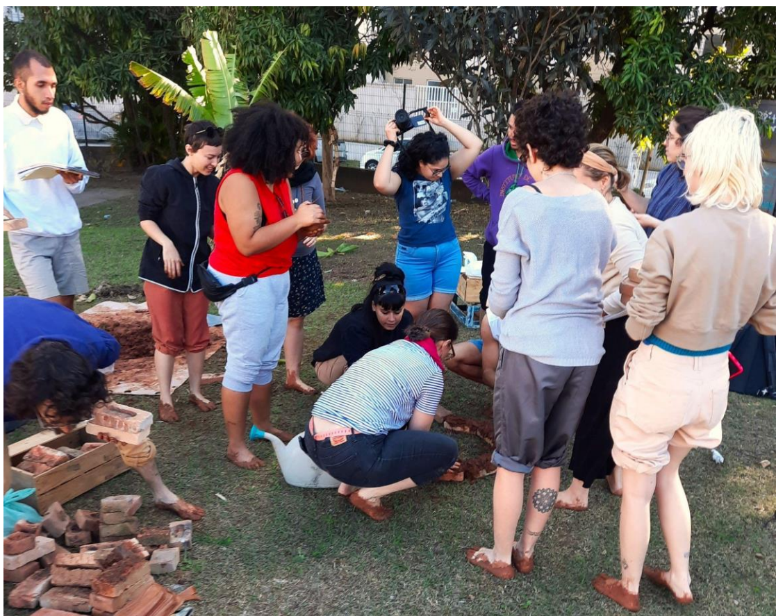
Imagem 1. início da construção do forno a lenha, 2023. Fonte: acervo pessoal
