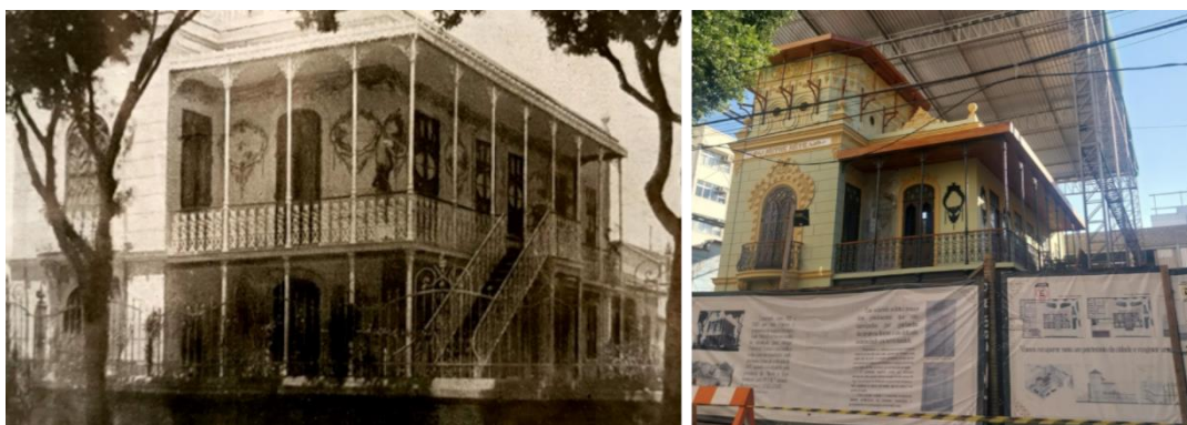
Figura 2 – Casa Norival de Freitas no século XX e atualmente em processo de restauração
