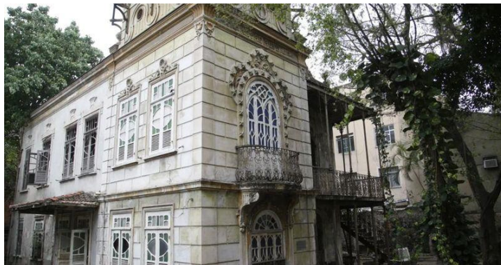
Figura 5 – Estado de deterioração da Casa Norival de Freitas em 2019.
