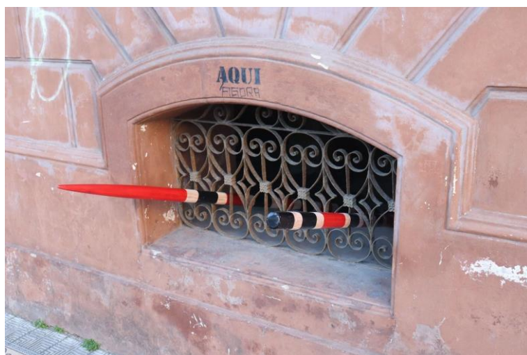
Imagem 9. Registro da instalação na fachada do casarão número 6, na Praça Coronel Osório. 2024.
