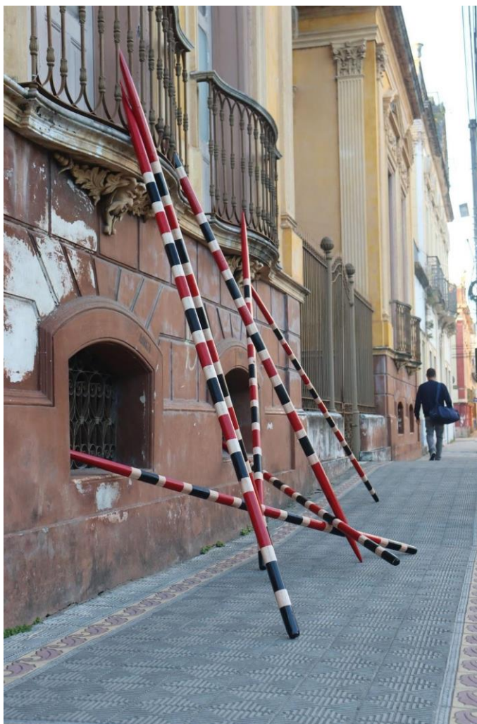
Imagem 8. Registro da instalação na fachada do casarão número 6, na Praça Coronel Osório. 2024.
