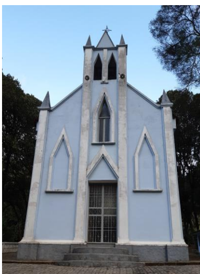
Imagem 10. Igreja de São Marcos, São Marcos – Alfredo Chaves. Datada de 1980. Fonte: fotografia do autor.
