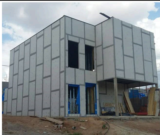
Figura 4. Construção próxima da fase de acabamento, mostrando o caráter pré-moldado da estrutura.
