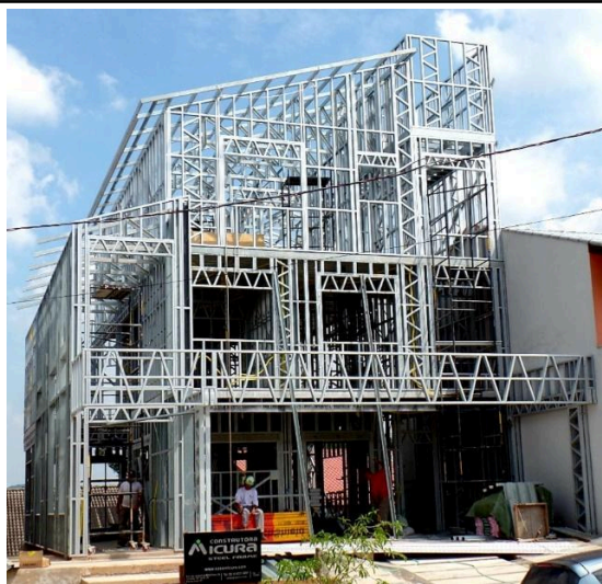
Figura 1. Construção seguindo sistema Light Steel Frame .
