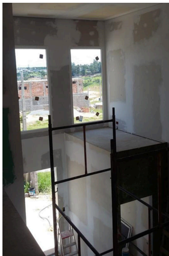
Figura 3. Placas cimentícias no interior do imóvel construído com perfis de aço.
