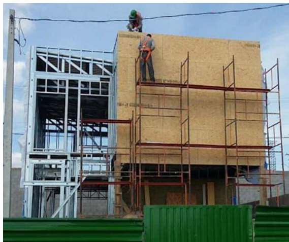
Figura 2. Obra limpa em execução no sistema LSF com instalação das placas cimentícias.
