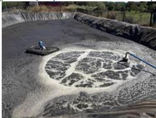
Figura 1. Esterqueira para armazenamento de resíduos líquidos
